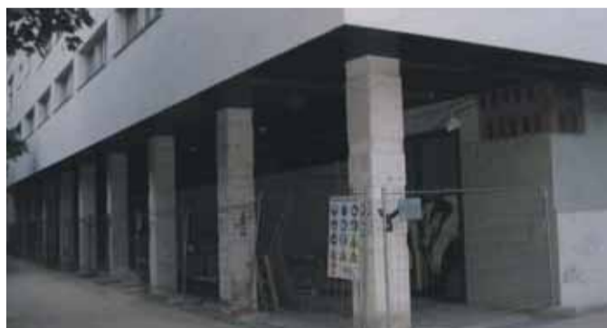
■ Obras de construcción de la nueva biblioteca.
